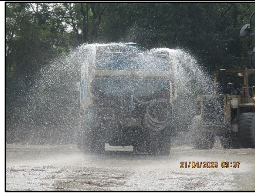
ภาพที่ 2.5 รถบรรทุกน้ำคอยฉีดพรมถนนภายในพื้นที่โครงการ
