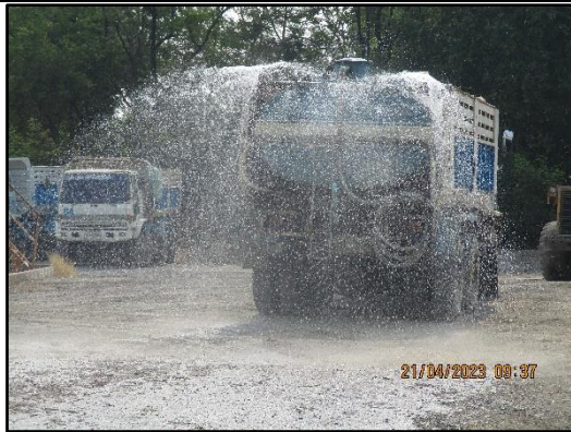
ภาพที่ 2.5 รถบรรทุกน้ำคอยฉีดพรมถนนภายในพื้นที่โครงการ
